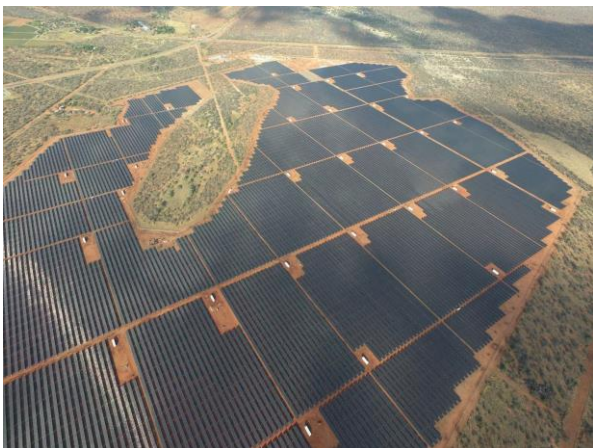
Impianto realizzato dall'Emittente in Sud Africa e completato nel 2016 con una potenza di 66,0 MW di cui 40MW installati da Comal.
